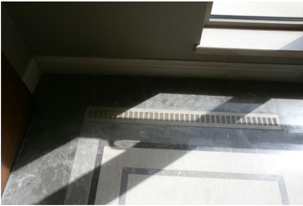
安装严密平整的地面出风口
