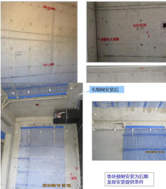
毛细管网施工前,将吊顶及墙面完成面线放出,并落实毛细管网区域位置
